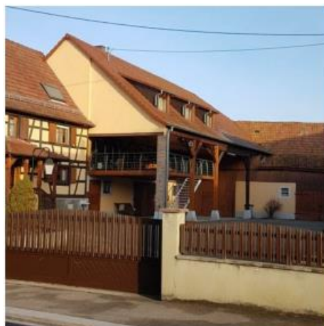
Création de logements par réhabilitation
