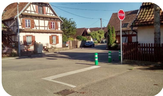
Mise en place d'un STOP avec une avancée d'un mètre, sécurisée par des plots pour assurer une meilleure visibilité et les déplacements des piétons.
