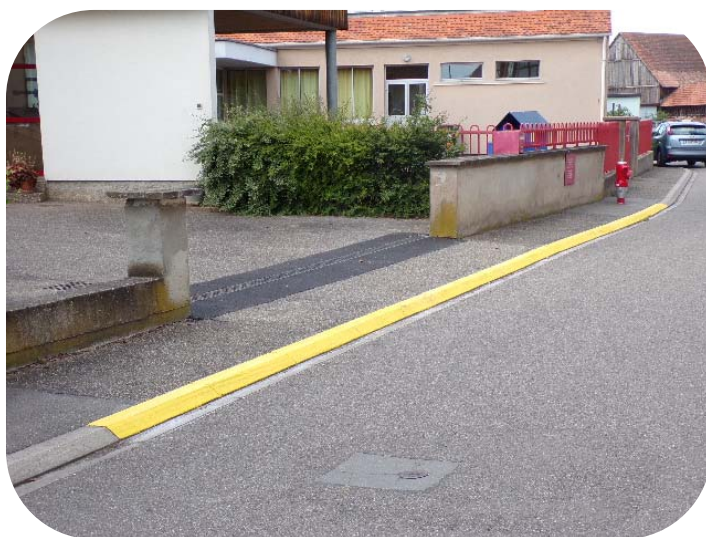
Interdiction de stationnement devant le local des pompiers matérialisée par une bande jaune afin de permettre la sortie de leur véhicule à tout moment.
